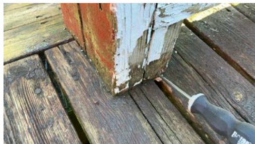
Fukt/råte skade
