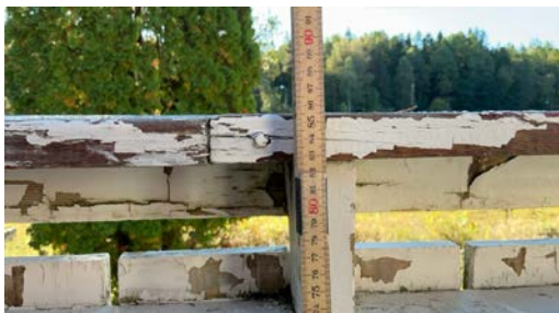
Rekkverk for lavt
