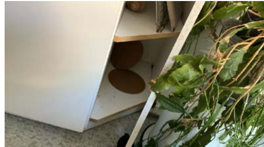
Hyller og dør med ender av sponplate
