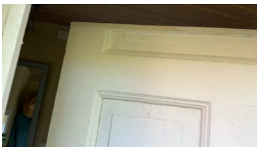
Ytterdør kappet av på høyden.
