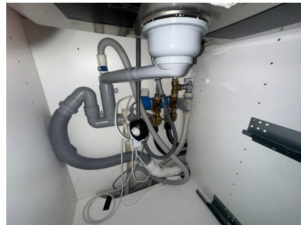
Røropplegg i kjøkkenbenk med Waterguard
