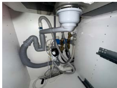
Røropplegg i kjøkkenbenk med Waterguard
