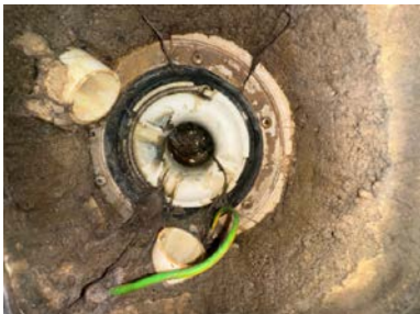
Sluk i plast, plassert i dusjnisje
