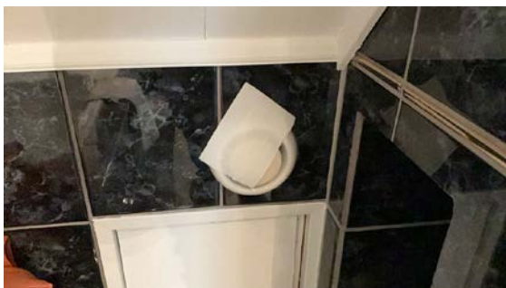
Test av avtrekk. Papiret henger.
