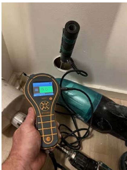
Det ble ikke registrert fukt i konstruksjon vegg ved hulltaking fra tilstøtende vegg.
