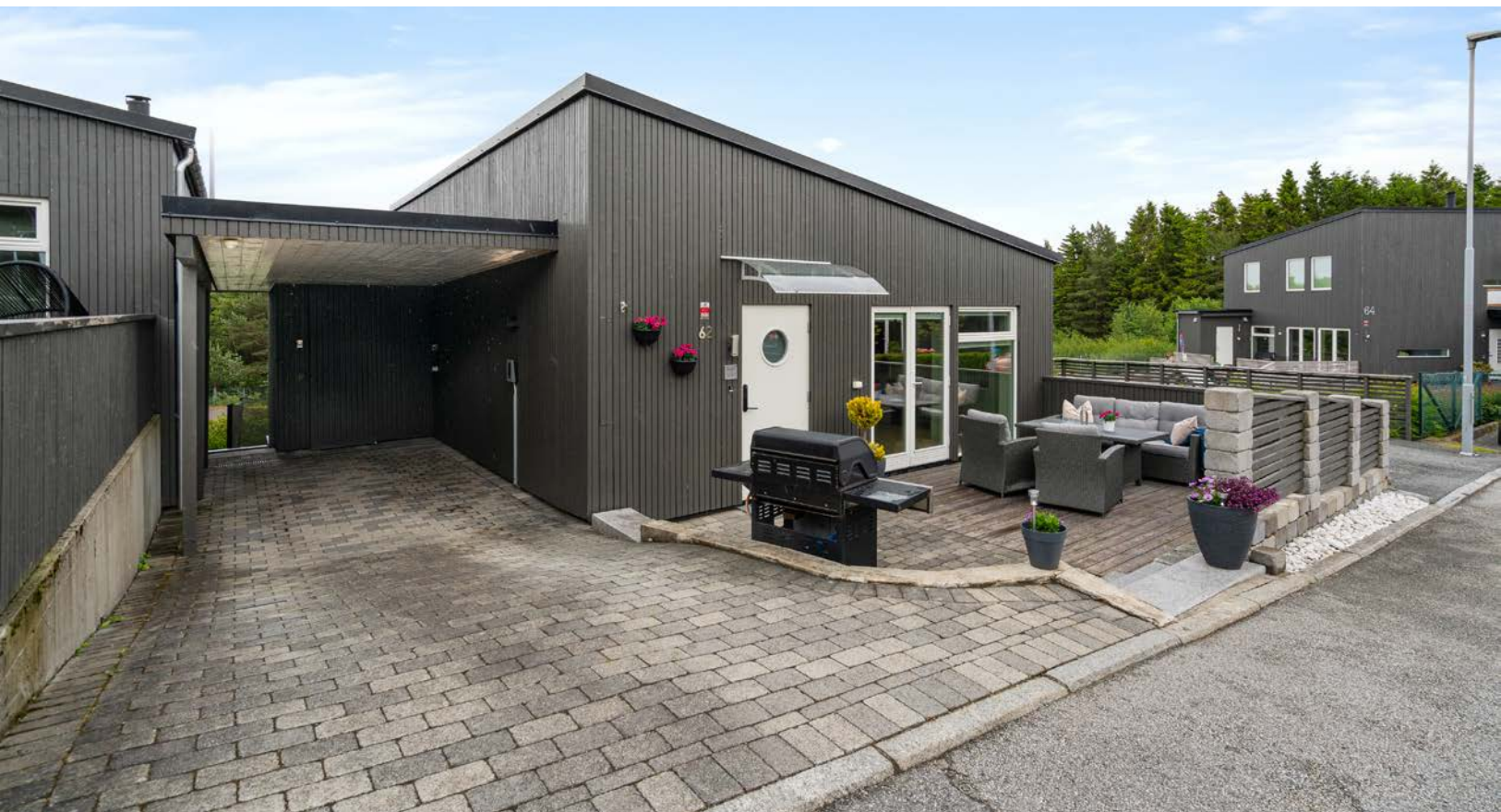
Carport med el-billader og varmekabler i gårdsrom.
