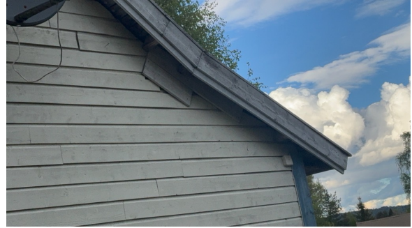
Stedvis enkle og manglende tilslutninger.
