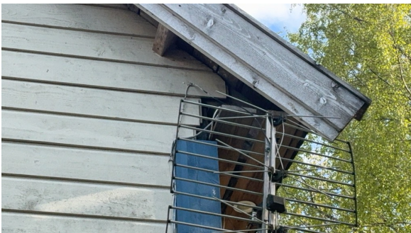
Eksempel på uferdig overgang
