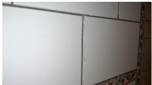
Påført silikon etter oppsprekking i fuger.
