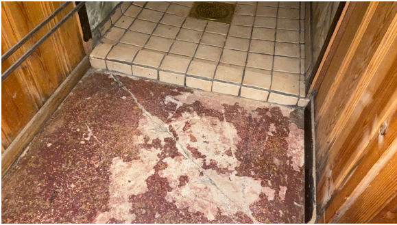
Avskaling på gulv og sprekk i gulv.
