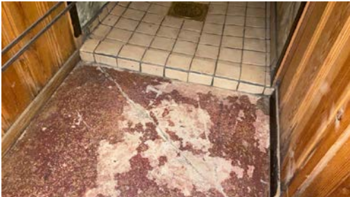
Avskaling på gulv og sprekk i gulv.
