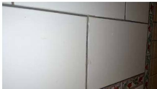
Påført silikon etter oppsprekking i fuger.
