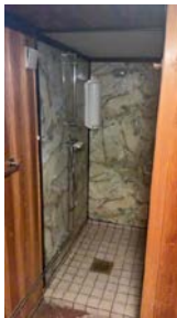
Avskaling på gulv og sprekk i gulv.
