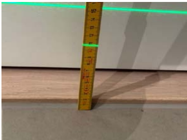
Fallforhold ca. 106 mm overkant gulv ved terskel
