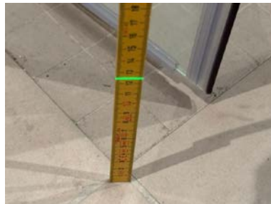
Fallforhold ca. 125 mm overkant gulv ved dusjsone
