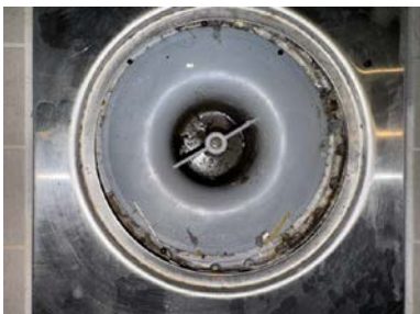
Plastsluk med klemring og synlig membran/mansjett
