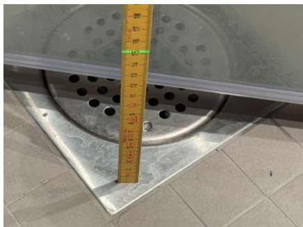
Fallforhold ca. 152 mm topp slukrist i dusjsone
