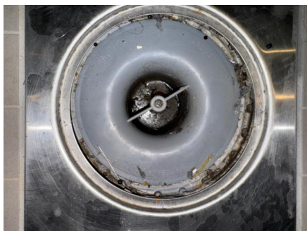
Plastsluk med klemring og synlig membran/mansjett
