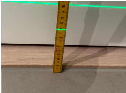
Fallforhold ca. 106 mm overkant gulv ved terskel
