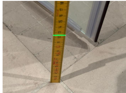
Fallforhold ca. 125 mm overkant gulv ved dusjsone
