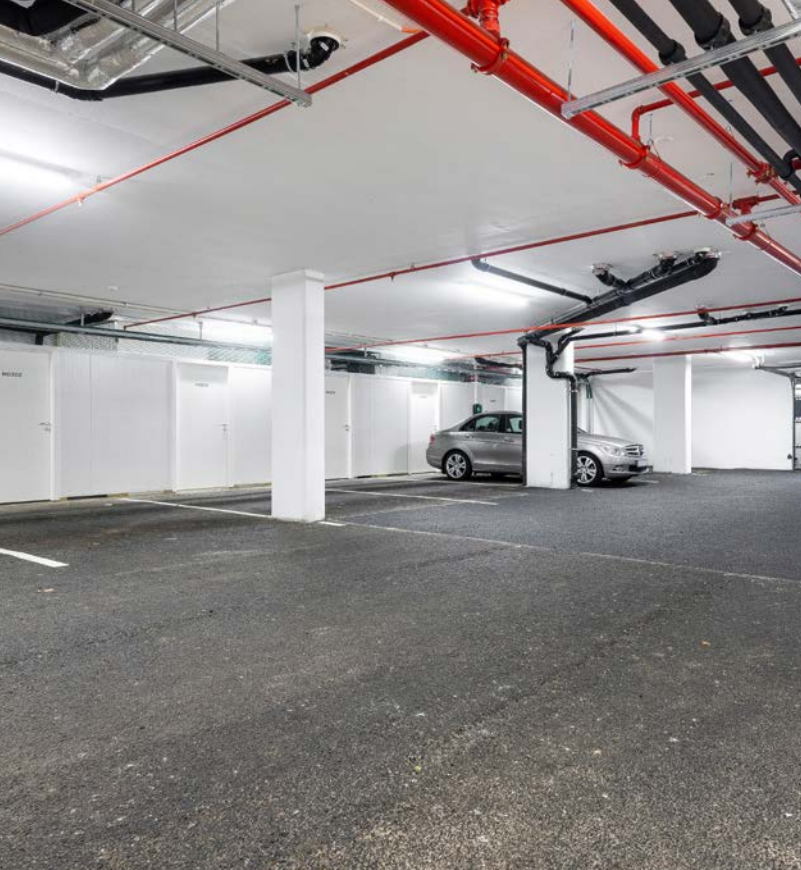
fast parkeringsplass i garasjeanlegg
