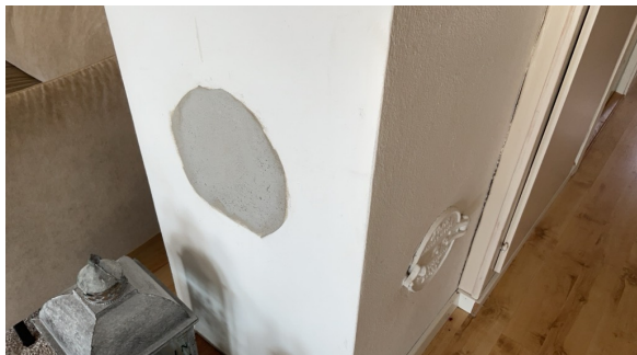
Tidligere hull til ildsted tettet.
