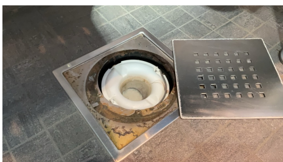
Kontroll av sluk.
