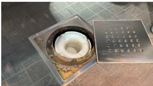
Kontroll av sluk.
