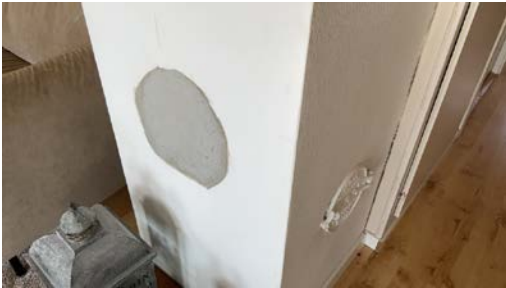
Tidligere hull til ildsted tettet.
