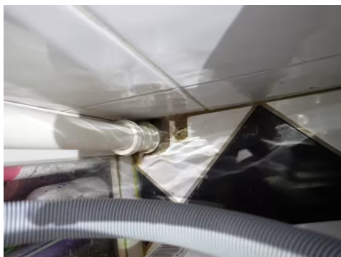
Utførelse ved rørføringer
