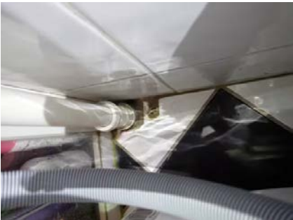
Utførelse ved rørføringer
