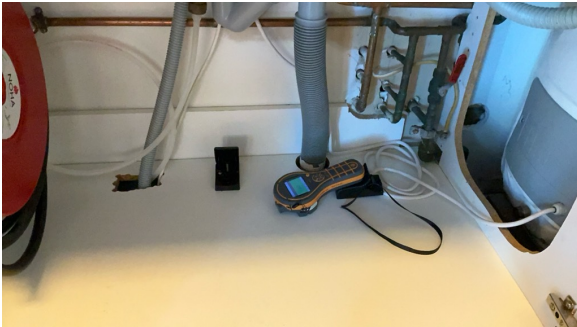
Ingen fuktighet registrert ved fuktsøk
