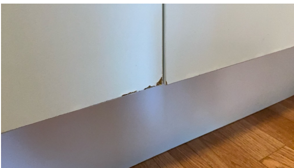
Skade på skapdør
