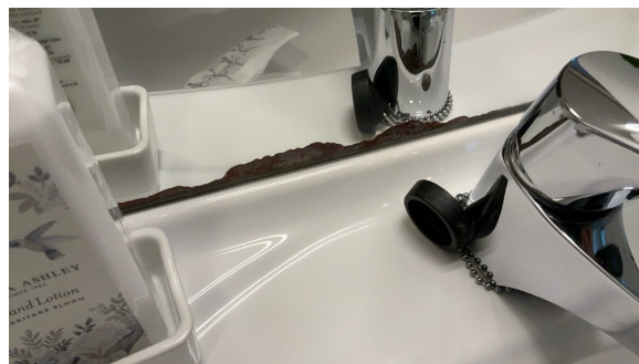
Fuktskade/misfarging i nedkant av speilet
