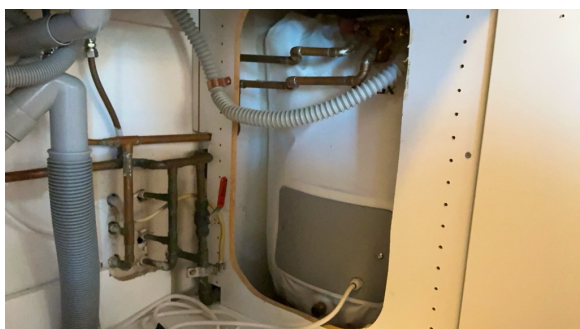
Bereder under benkeskap på kjøkken
