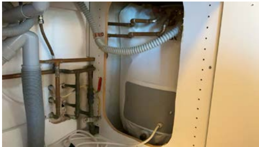
Bereider under benkeskap på kjøkken
