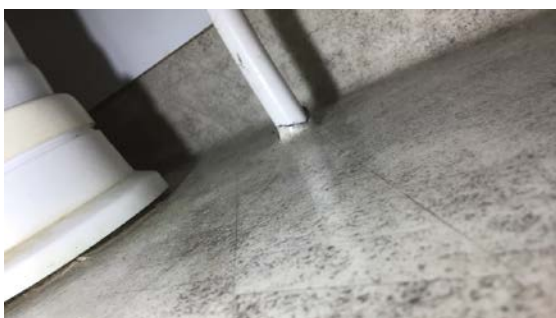
Utetthet i belegg rund rør
