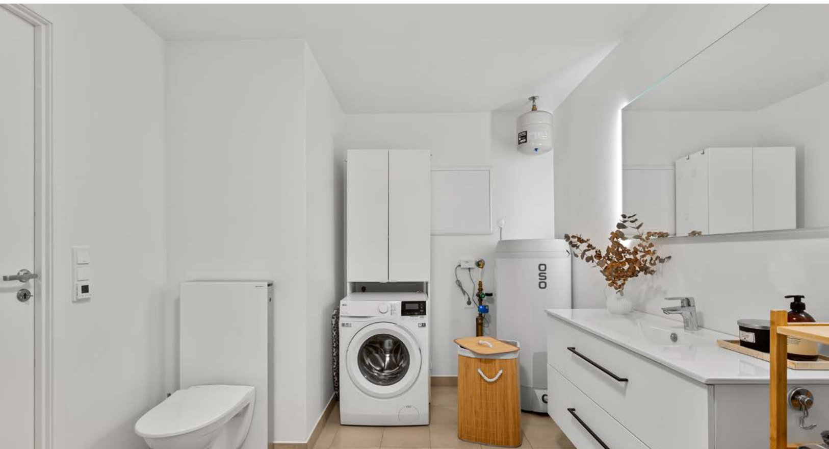
Her er vegghengt toalett og opplegg for vaskemaskin.
