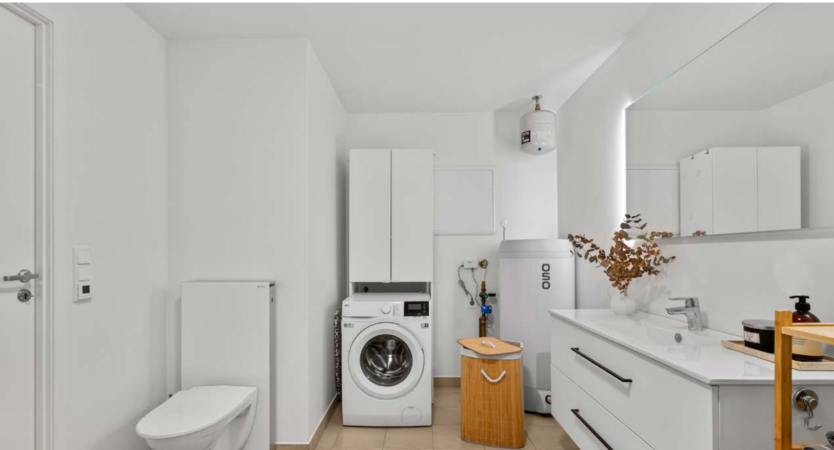
Her er veggheengt toalett og opplegg for vaskemaskin.
