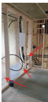
Synlige rørføringer (vann og el) i veggen mot soverommet.
