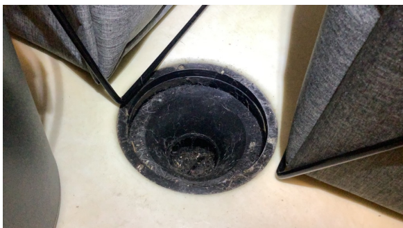
Plastsluk på gulv, og vinylbelegget er ført under slukets klemring.
