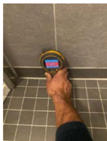
Forhøyede verdier ved fuktsøk.
