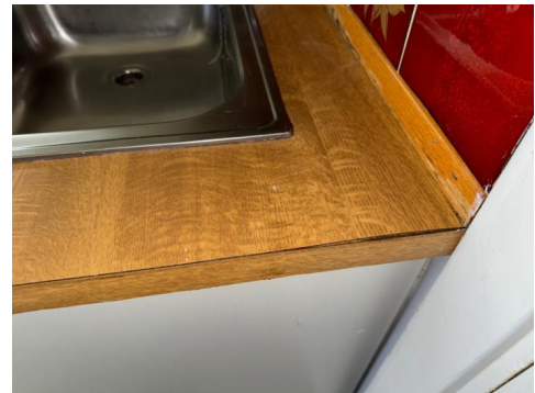
Fuktskadet benkeplate
