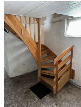
Forhøyet fuktnivå (24,4 vektprosent) på trappevange mot kjellergulv
