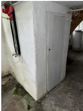
Enkel plassbygget "skapdør" til toalettrom i kjeller
