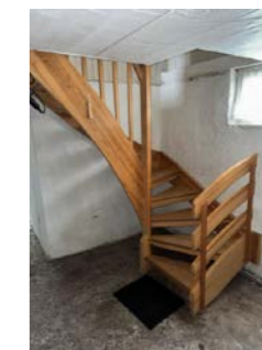
Forhøyet fuktnivå (24,4 vektprosent) på trappevange mot kjellergulv
