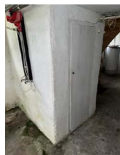
Enkel plassbygget "skapdør" til toalettrom i kjeller
