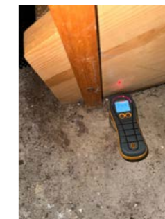
Forhøyet fuktnivå (24,4 vektprosent) på trappevange mot kjellergulv
