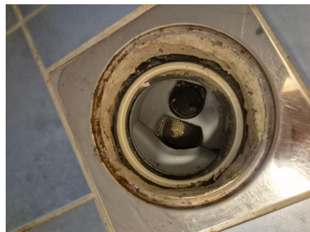
Sluk under innredning.
