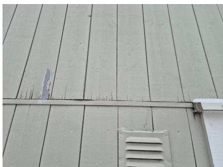
Råteskadet kledningsbord.
