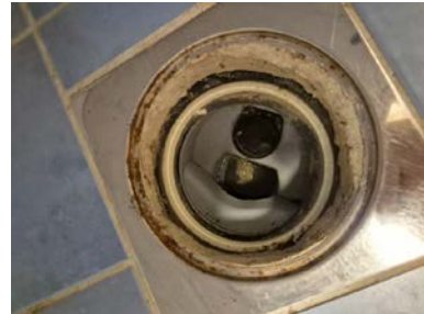
Sluk under innredning.
