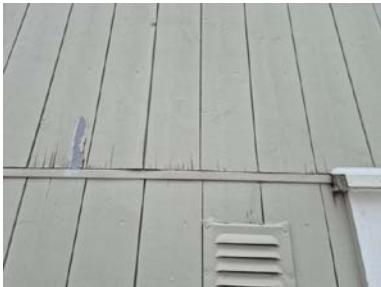
Råteskadet kledningsbord.
