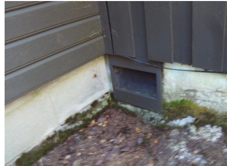
Ringmur tilbygget og opprinnelig del.
