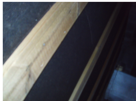
Deler av stubbloftet under tilbygget del.
