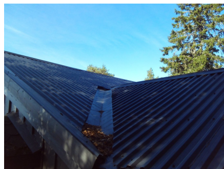
Sammenføyning til tilbygget del.
