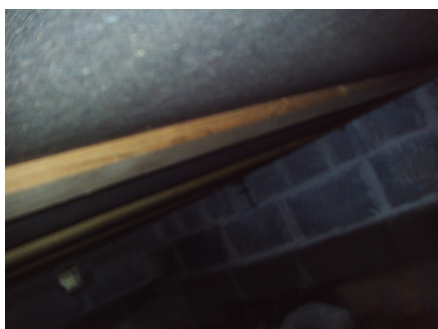
Deler av krypkjeller under tilbygget del.
