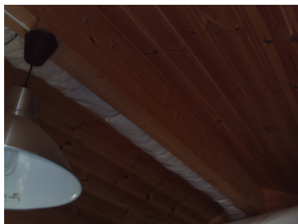
Lukket takkonstruksjon i tilbygget bod.
