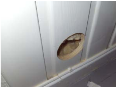
Hulltaking er foretatt i fra soverommet.
