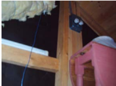
Hovedinntaket på kaldtloftet.
