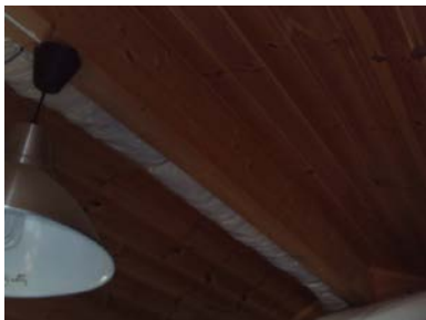
Lukket takkonstruksjon i tilbygget bod.
