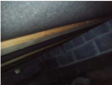
Deler av kryp kjeller under tilbygget del.
