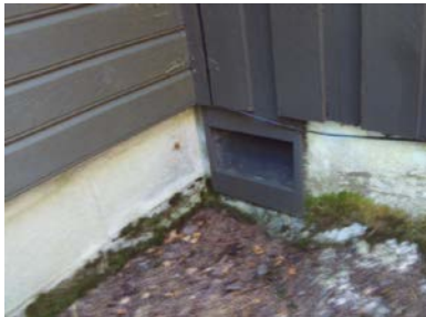
Ringmur tilbygget og opprinnelig del.
