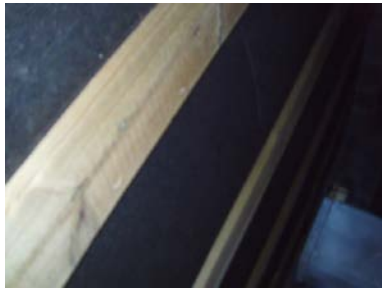
Deler av stubbloftet under tilbygget del.
