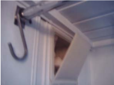
Ventil i ytterveggen
