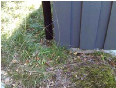
Kledningenb nær bakkenivå på ene ytterhjørne.
