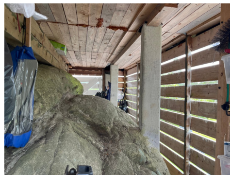
Kryperom under tilbygg vest.
