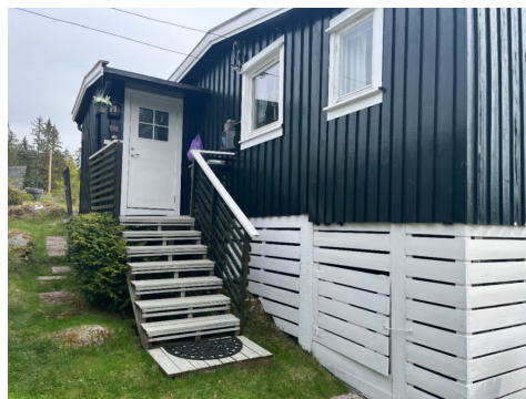
Terrasse og trapp til inngangsparti.
