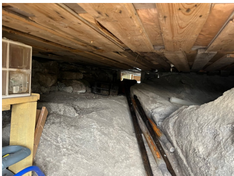
Krypkjeller med gjennomventilering.
