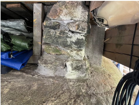
Variierende fundamentering av hytta.
