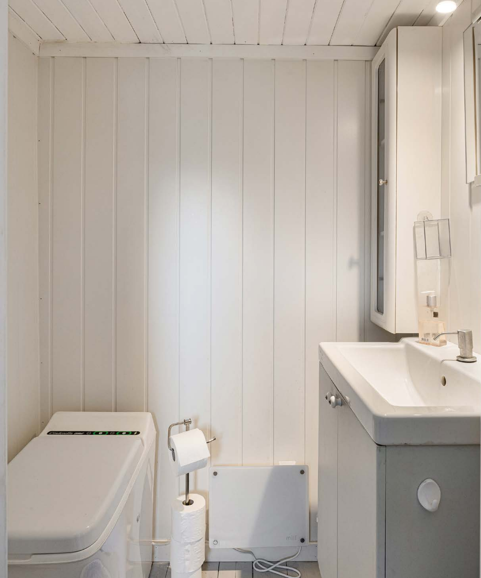
Et Cinderella forbrenningstoalett er montert, og rommet har et servantskap, to veggskap med glassfronter og et speil med belysning.
