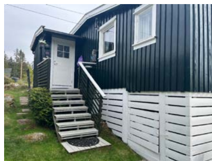
Terrasse og trapp til inngangsparti.
