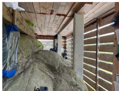
Kryperom under tilbygg vest.
