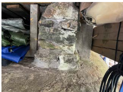
Variierende fundamentering av hytta.
