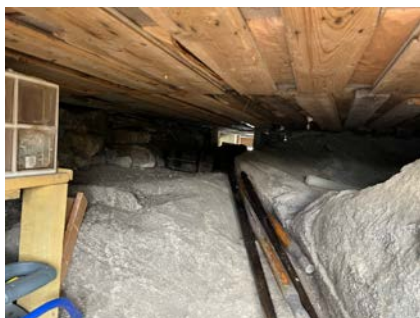
Krypkjeller med gjennomventilering.
