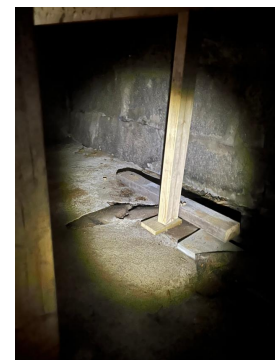
Viser støttestolper til bjelkelag i gammel del.
