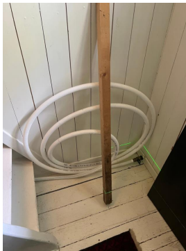
Viser vannledning frem til gammel del.
