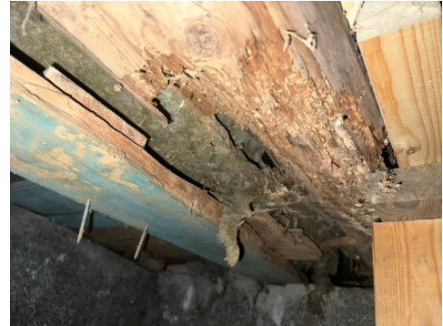
Viser råteskader i bjelkelag i gammel del.
