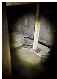
Viser støttestolper til bjelkelag i gammel del.
