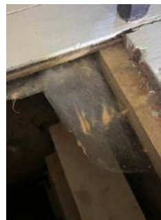
Viser spo etter aktive borebiller i gammel del ved kjellerluke fra gammelt kjøkken.
