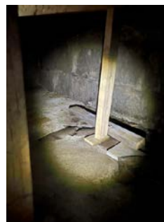
Viser støttestolper til bjelkelag i gammel del.
