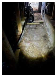
Viser råteskader i bjelkelag i gammel del.
