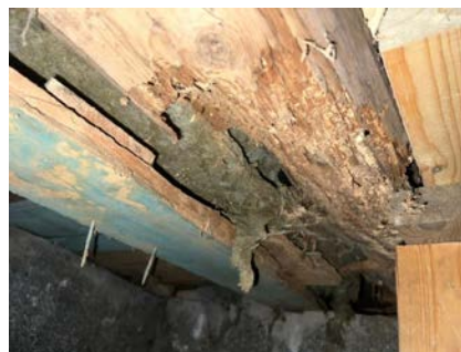
Viser råteskader i bjelkelag i gammel del.
