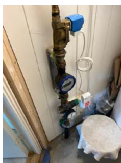
Viser vannledning frem til gammel del.
