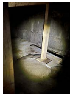
Viser støttestolper til bjelkelag i gammel del.
