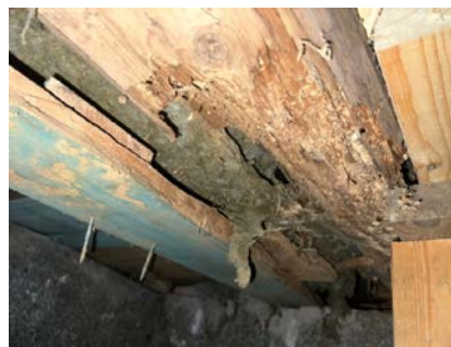
Viser råteskader i bjelkelag i gammel del.
