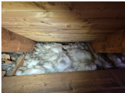
Tettet igjen for luftespalte.
