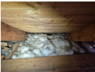
Tettet igjen for luftespalte.
