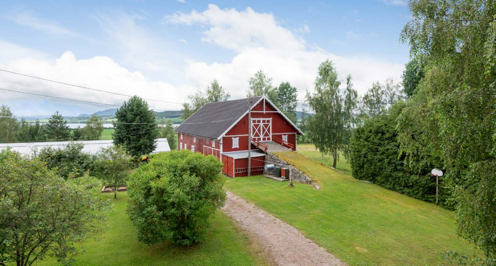
Låven har et bruksareal på ca. 294m 2 og inneholder bla. garasje, fjøs, traktorrom, hønserom, kornrom, utedo, lagerrom og gjødselkjeller. Bygget er gammelt og bærer preg av manglende vedlikehold og oppgraderinger.
