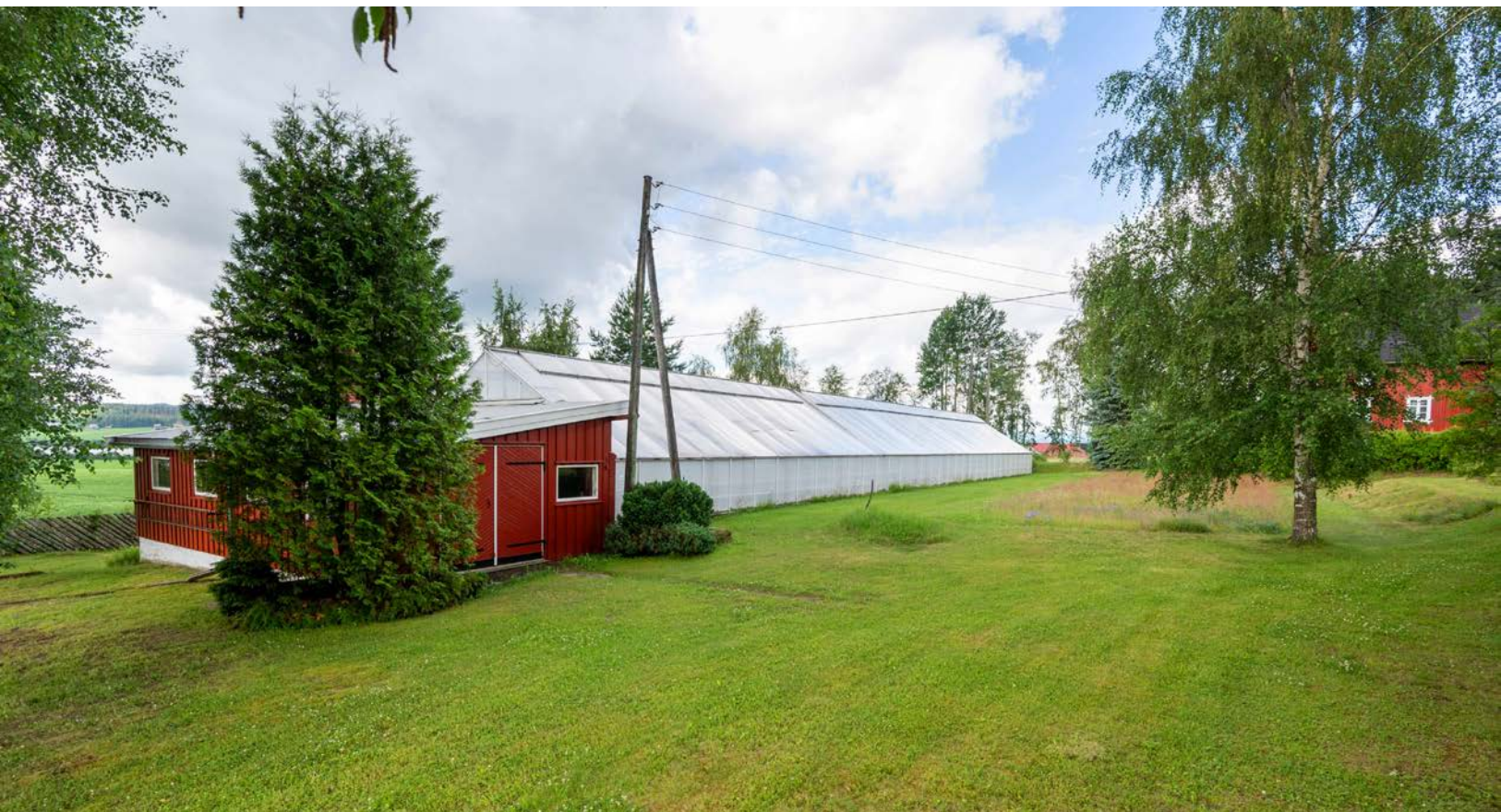
Veksthuset som ble bygd i 1969 har et bruksareal på ca. 408m 2 som i hovedsak består av 2 store drivhus og lagerrom i 1. etasje, samt lagerrom og fyrrom i kjelleren.
