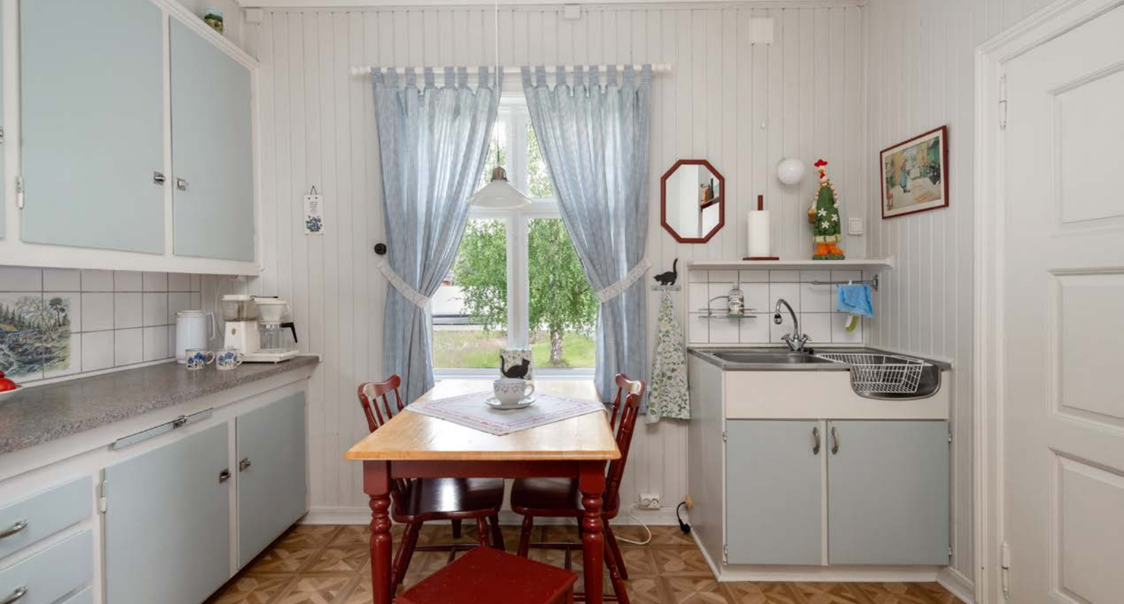
Eldre kjøkkeninnredning med glatte fronter, laminert benkeplate, benkebeslag med nedfelt oppvaskkum og fliser i benkeryggen.
