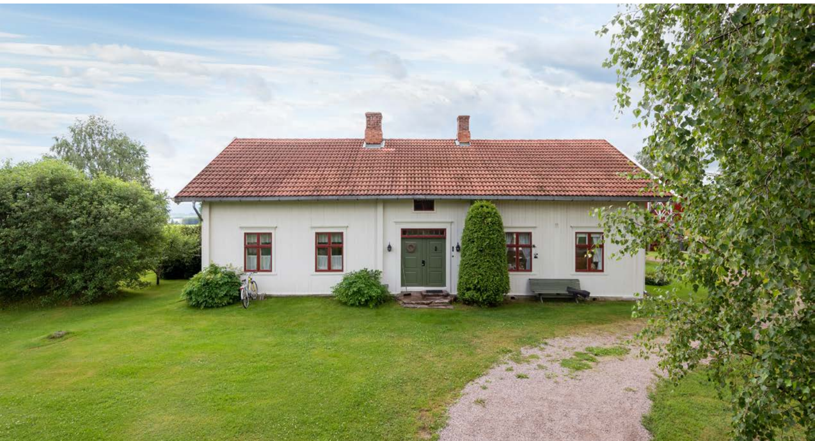
Sjarmerende enebolig antatt bygget i perioden 1800-1820. Boligen har yttervegger av laftet tømmer som er kledd med stående panel og tak tekket med betongtakstein fra 1975.
