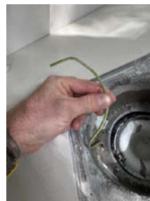
Jordingskabelen var ikke festet til slukristen på befaringsdagen.
