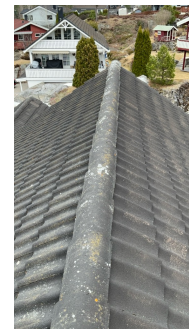
Taktekking er delvis mosegrodd, anbefales fjernet fordi det forkorter levetiden til tekkingen.
