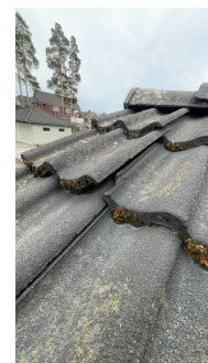
Taktekking er delvis mosegrodd, anbefales fjernet fordi det forkorter levetiden til tekkingen.
