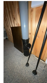
Stakeluke er plassert i bod i underetasje.
