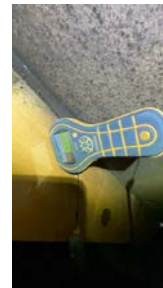
Ved enkel fuktmåling registrerte jeg tørre verdier.
