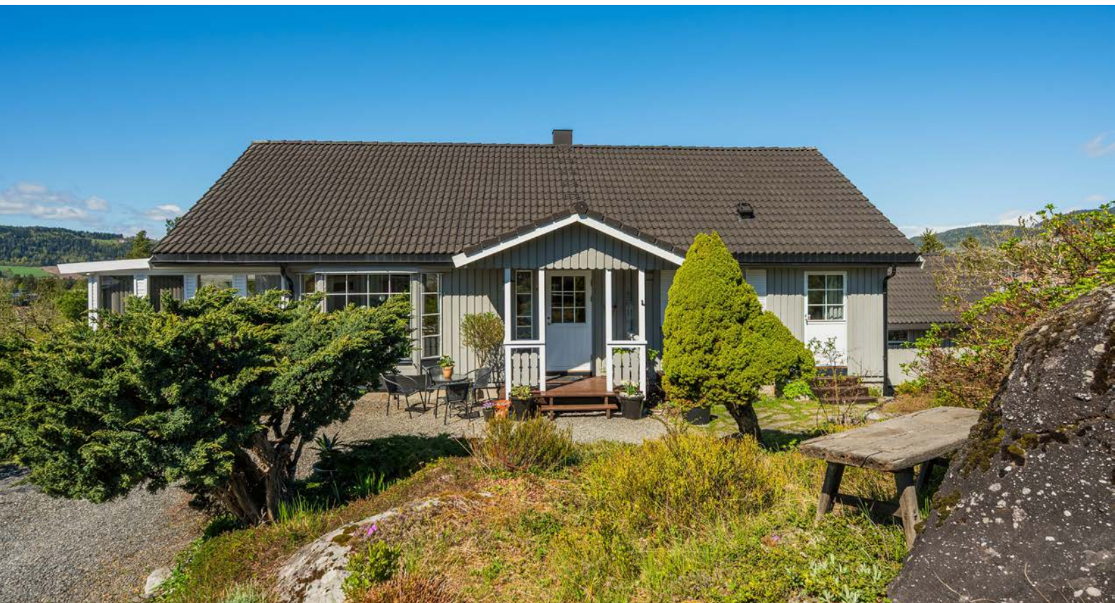
Boligen har yttervegger med stående trekledning, vinduer med 3-lags isolerglass og tak tekket med betongtakstein.
