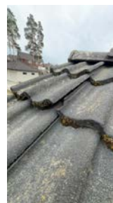
Taktekking er delvis mosegrodd, anbefales fjernet fordi det forkorter levetiden til tekkingen.
