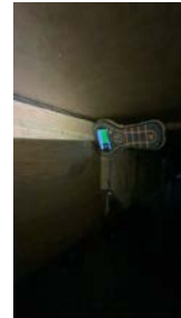
Fuktmåling ble foretatt, jeg målte tørre verdier i trevirke.
