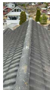
Taktekking er delvis mosegrodd, anbefales fjernet fordi det forkorter levetiden til tekkingen.
