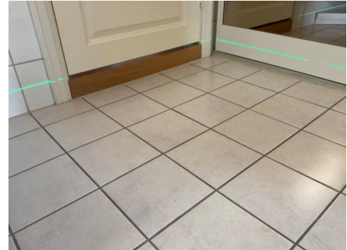
Oppkant dørterskel og gulvskinne på garderobeskap
