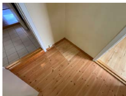
Reparasjon på kjøkkenbelegg
