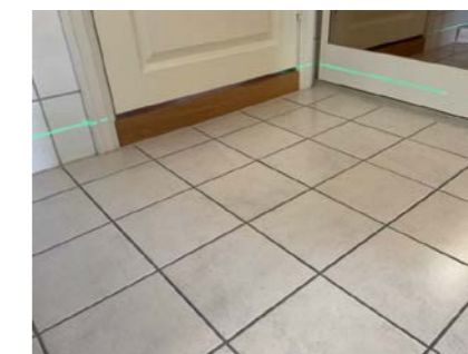
Oppkant dørterstel og gulvskinne på garderobeskap
