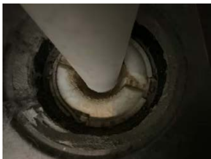
Hjelpesluk under badekar. Klemring og membran er skjult av fliselim.
