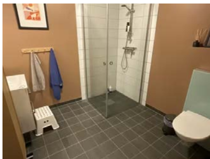
Bad med flislagte overflater gulv, samt vegger i dusjsone. Malte strie på resten. Innredning med servant, vegghengt klosett og dusjdører.
