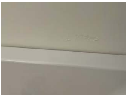
To småskader i strietapet ved badekar, disse stammer fra et stellebord. Punkter har blitt forsegle med våtromsmaling.
