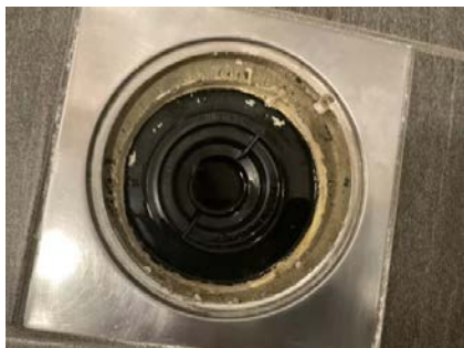
Plastsluk med klemring og membran.
