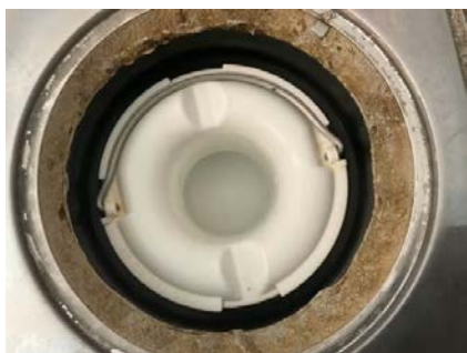
Sluk i dusjsone. Plastsluk med synlig membran, men klemring er skjult av fliselim.
