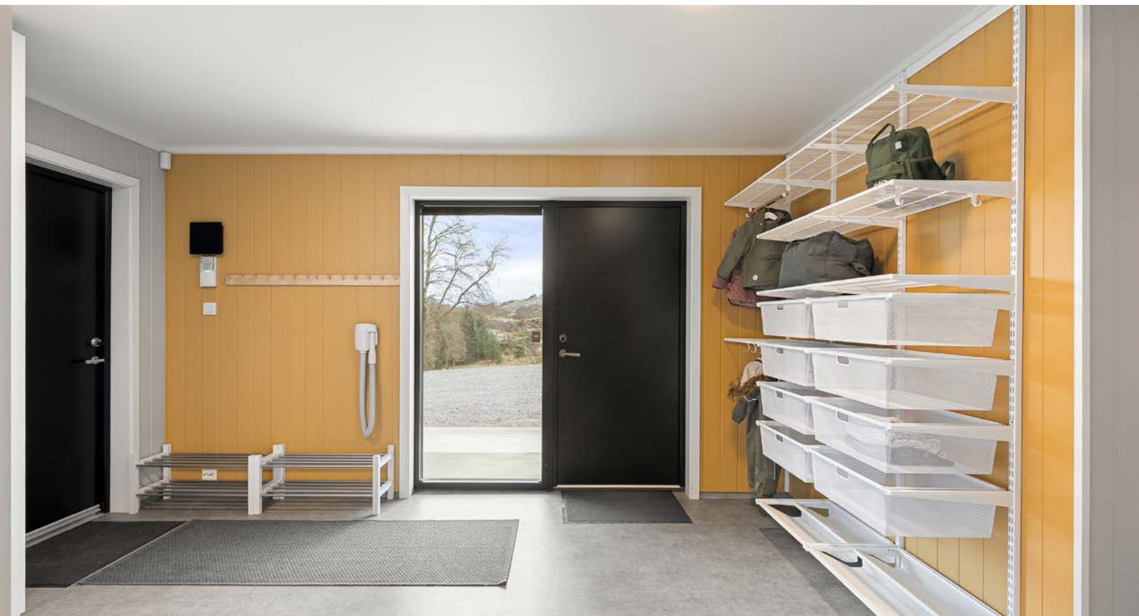
Sluse til garasje - WallyFlex sentalstøvuger for mindre lokal støvsuging.
