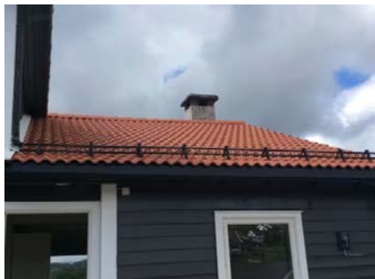
Nye renner, takpanner og beslag.
