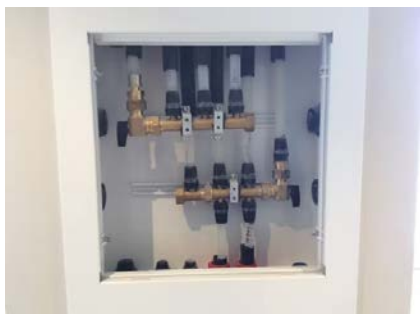
Nytt rør-rør-opplegg i hele leiligheten.
