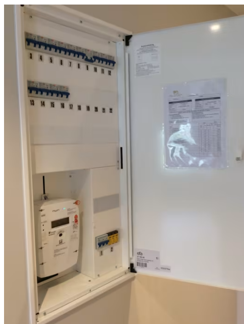
Komplett nytt elektrisk anlegg i leiligheten.
