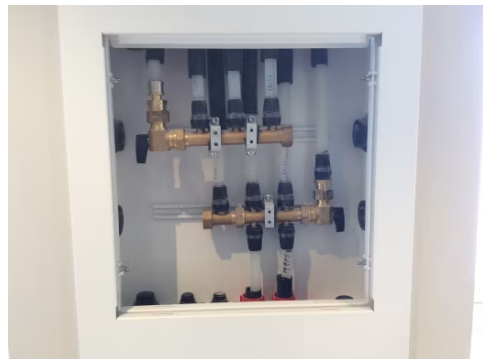
Nytt rørirør-opplegg i hele leiligheten.
