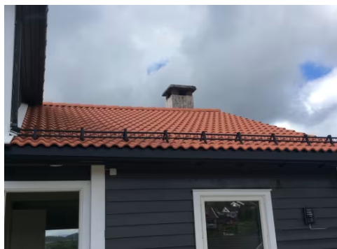
Nye renner, takpanner og beslag.
