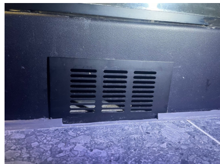
Rist under dusjgulv
