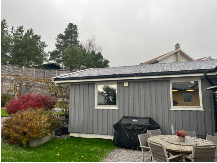
Synlig fuktsikring på utside av grunnmur
