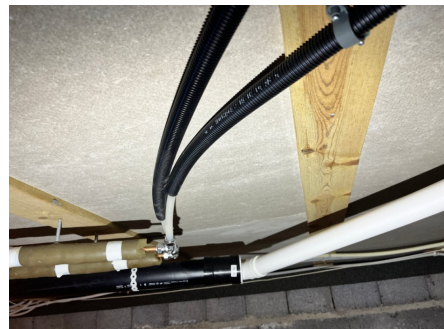
Uisolert vannledning
