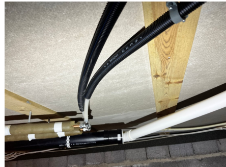
Uisolert vannledning
