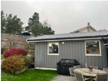
Synlig fuktsikring på utside av grunnmur
