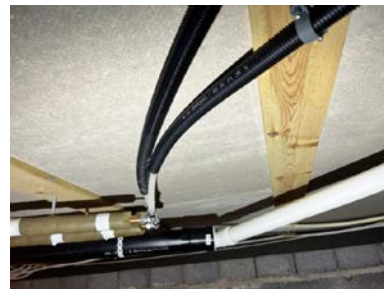
Uisolert vannledning
